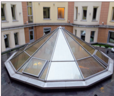
«Внутренний двор» отеля — светопрозрачные конструкции над лобби. Регулярная мойка проводится работниками той же компании, которая предоставляет персонал для хозяйственной службы гостиницы.
